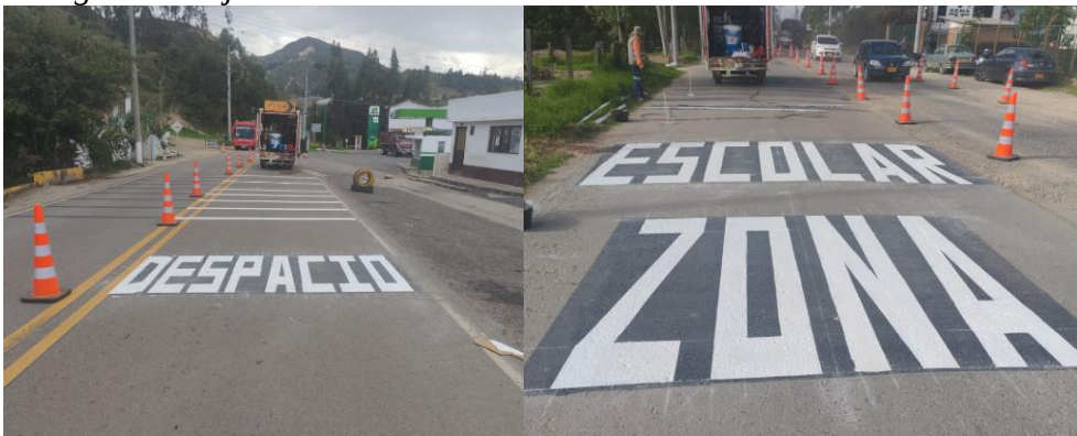
Figura 14 Ejecución Señalización Del Corredor Vial I.E UNAD-Sena
